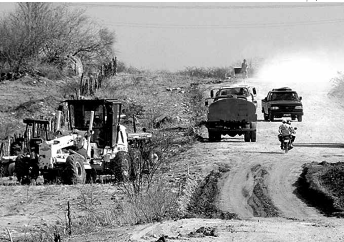
As obras da rodovia já foram iniciadas e a previsão é que sejam concluídas em junho de 2013
