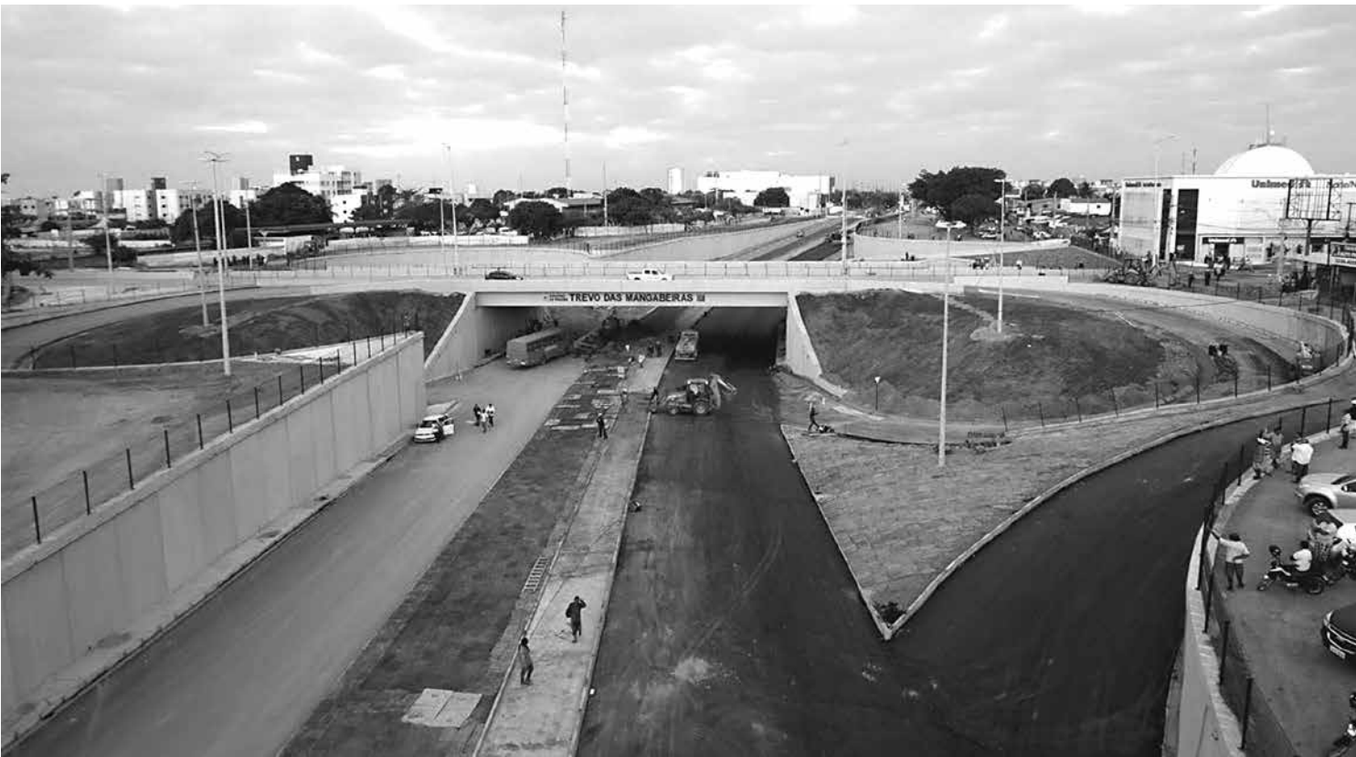
Trevo fica localizado na região de interseção das Avenidas Hilton Souto Maior, Josefa Taveira e Walfrido Brandão, ao lado da sede da Cehap
