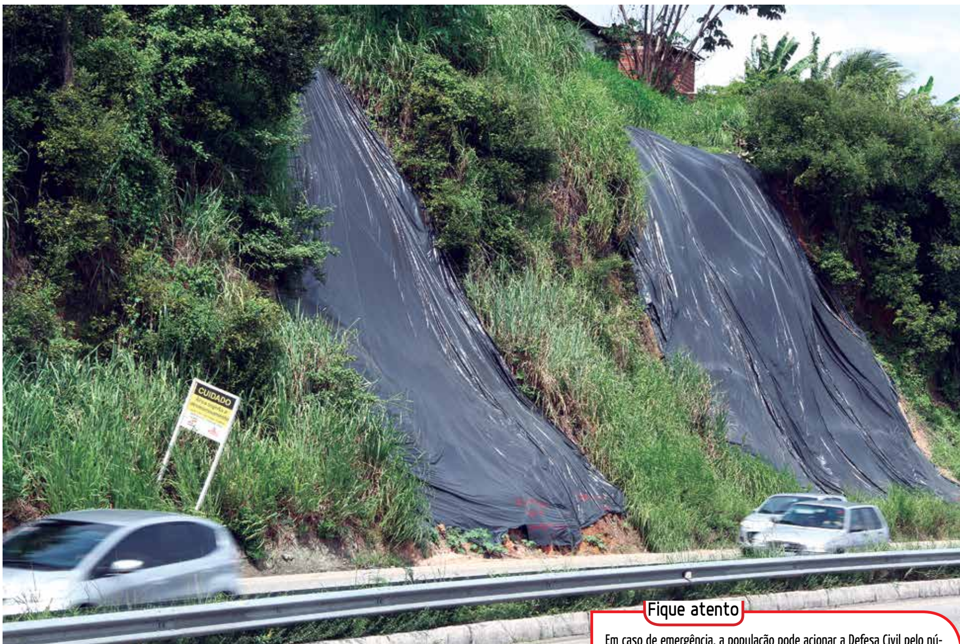
Na barreira do Castelo Branco são colocadas lonas, desde o ano passado, para evitar deslizamentos
