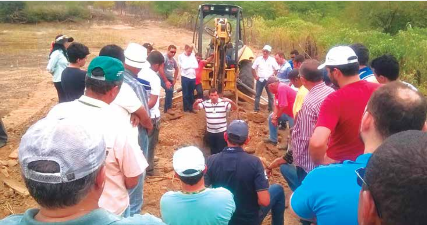
Fornecimento de mão de obra para construção será do município; acima, palestra sobre técnicas para implantação da barragem
