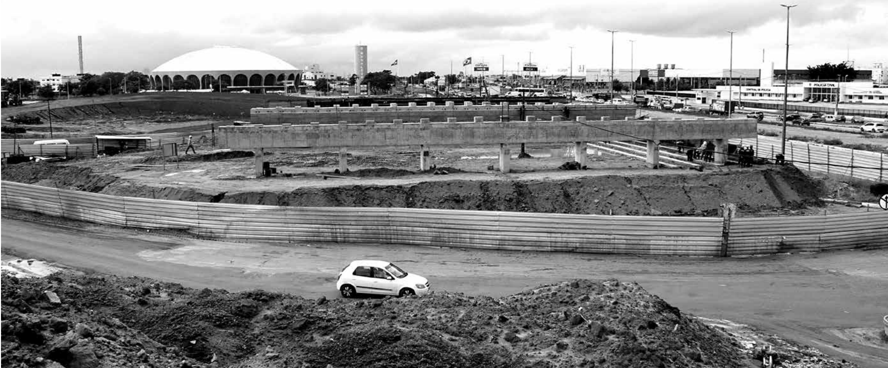
Toda a fundação da obra já está pronta, assim como as ferragens e o preenchimento em concreto dos pilares; investimento é de mais de R$ 38 milhões
