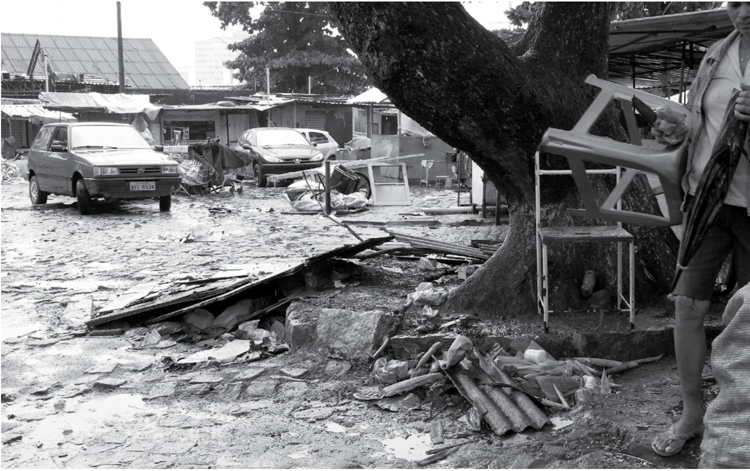
Problemas estruturais, como desordenamento das barracas, presença de vendedores ambulantes e sujeira prejudicam os comerciantes
