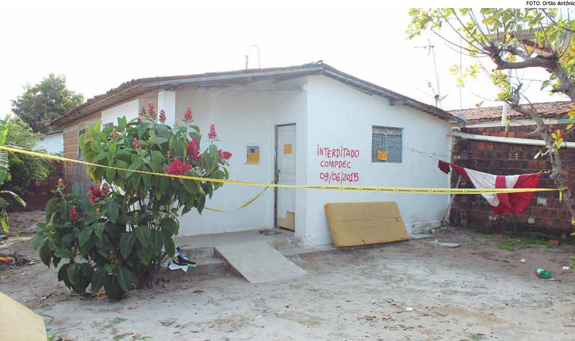
A descoberta da casa, que foi interditada, aconteceu durante diligências para reprimir o tráfico de drogas, crimes contra o patrimônio e busca por assaltantes de bancos
