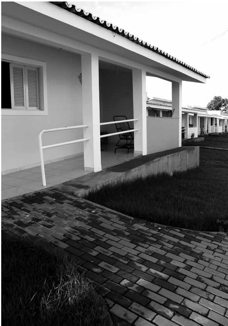
Na entrada de todas as casas do condomínio foram construídas rampas para cadeirantes
