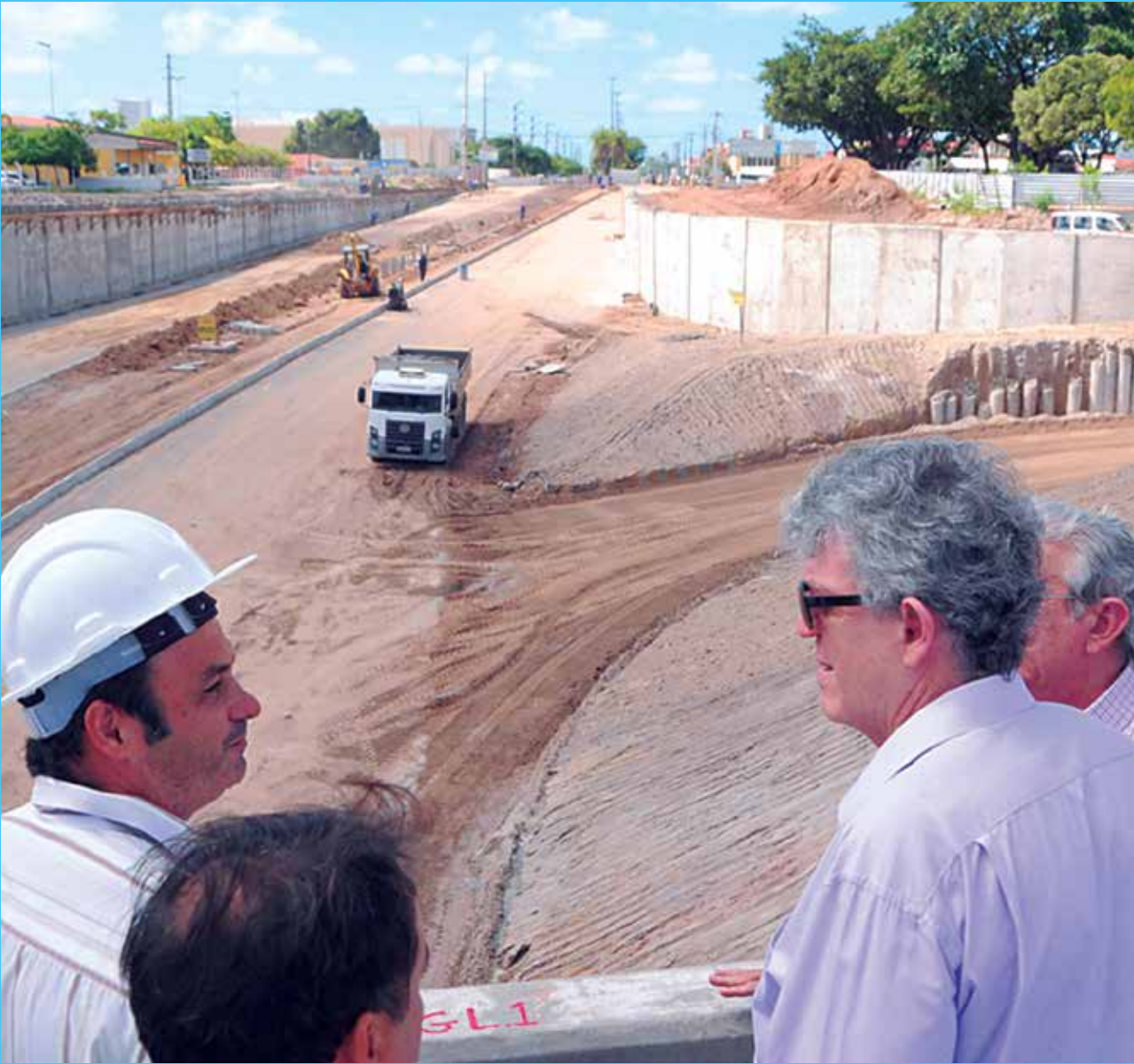
Anúncio da inauguração das obras foi feito ontem, durante inspeção realizada pelo governador Ricardo Coutinho
