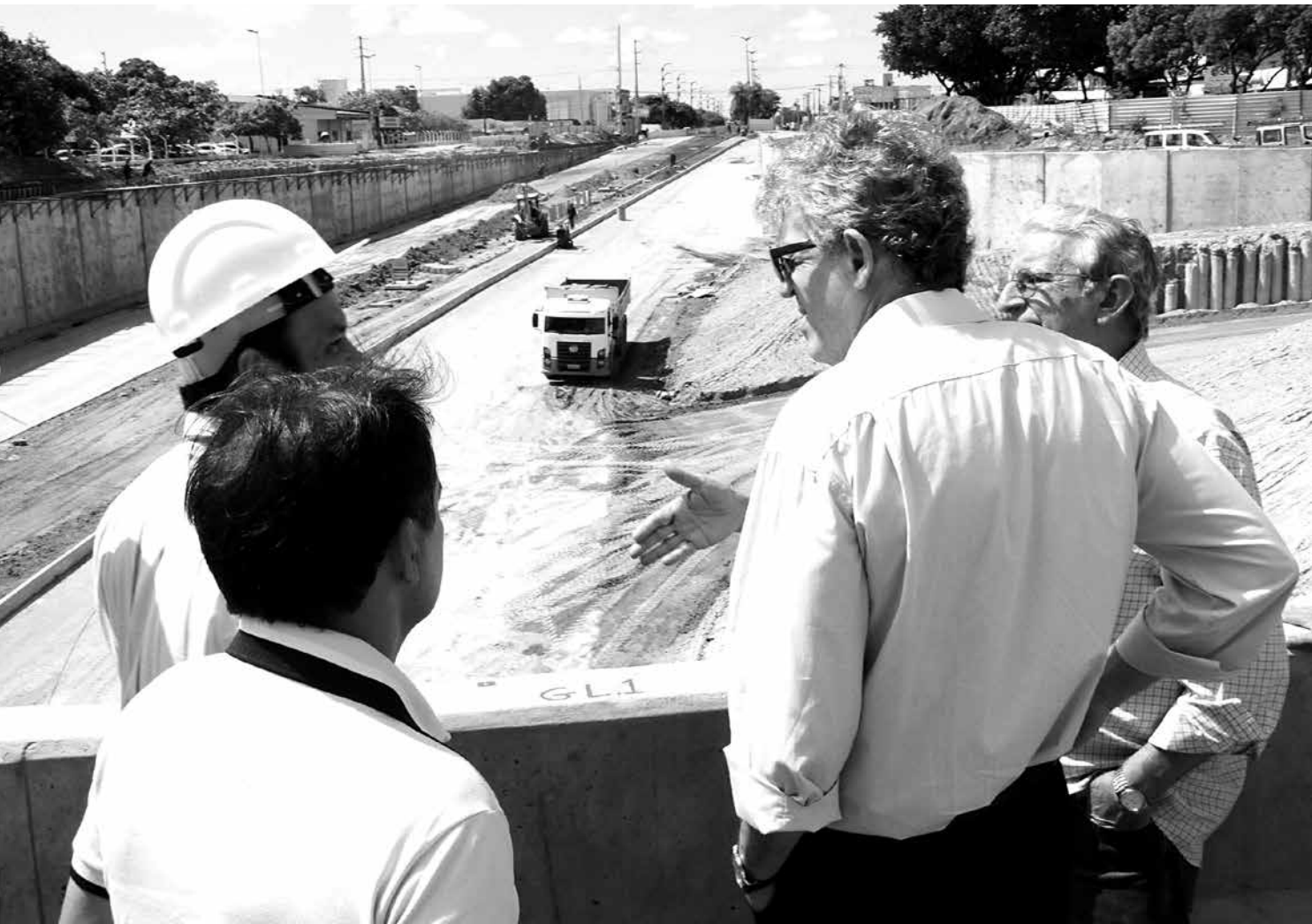
O governador Ricardo Coutinho e sua comitiva inspecionaram obras que já se encontram em fase de conclusão em João Pessoa
