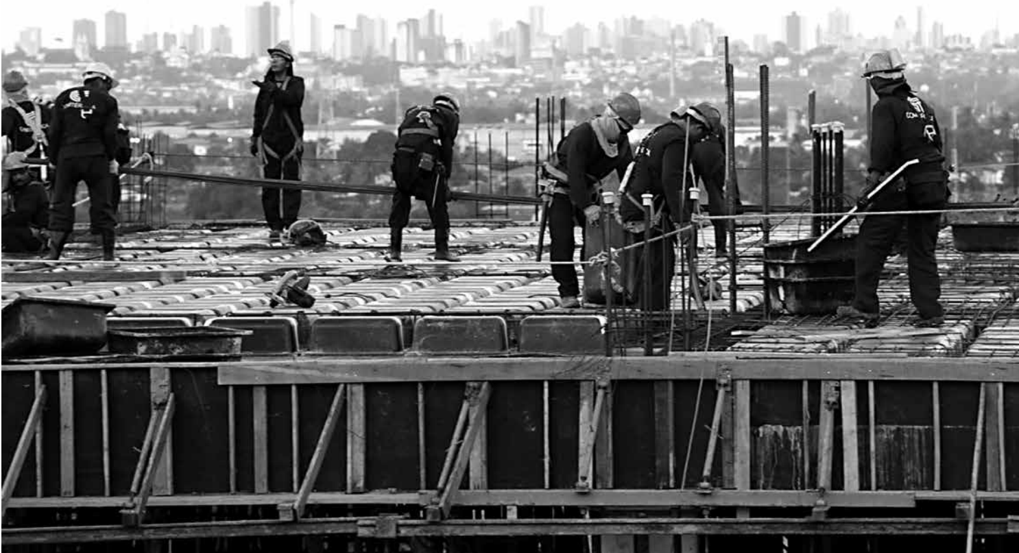
O hospital está sendo construído em um terreno de 28 mil m²; são 130 operários em atividade, entre montadores e armadores
