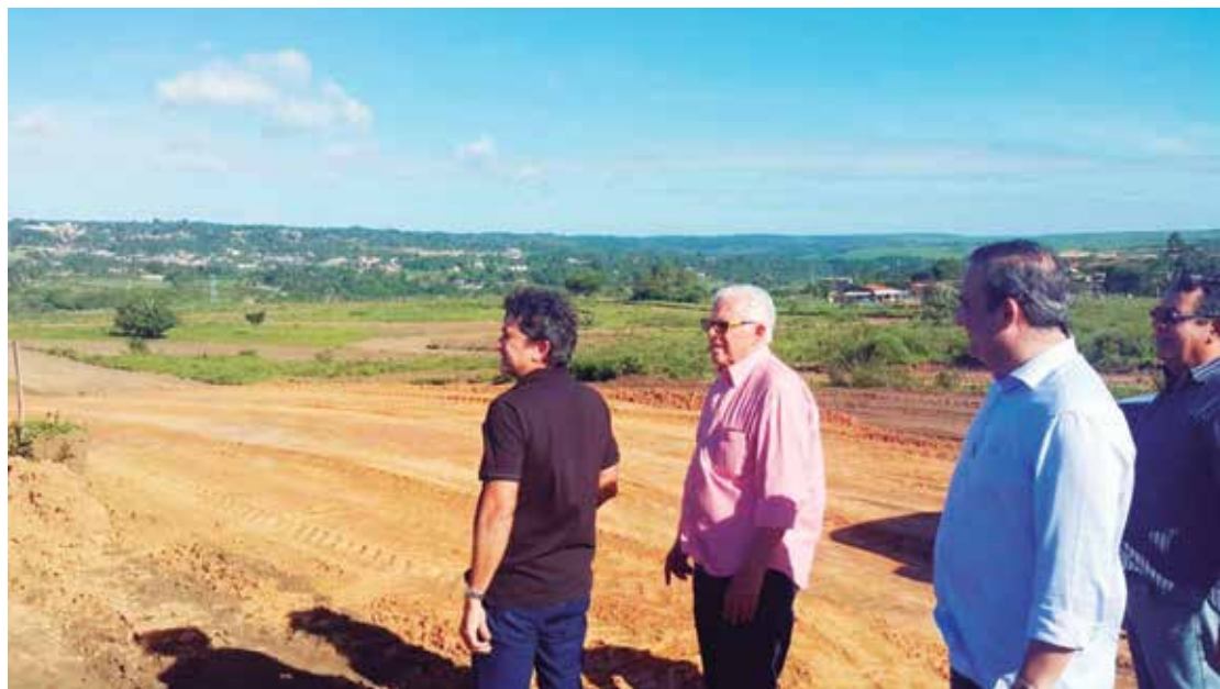
Em visita ao local das obras, presidente da CBA Cleyton Pinheiro ficou surpreso com andamento
