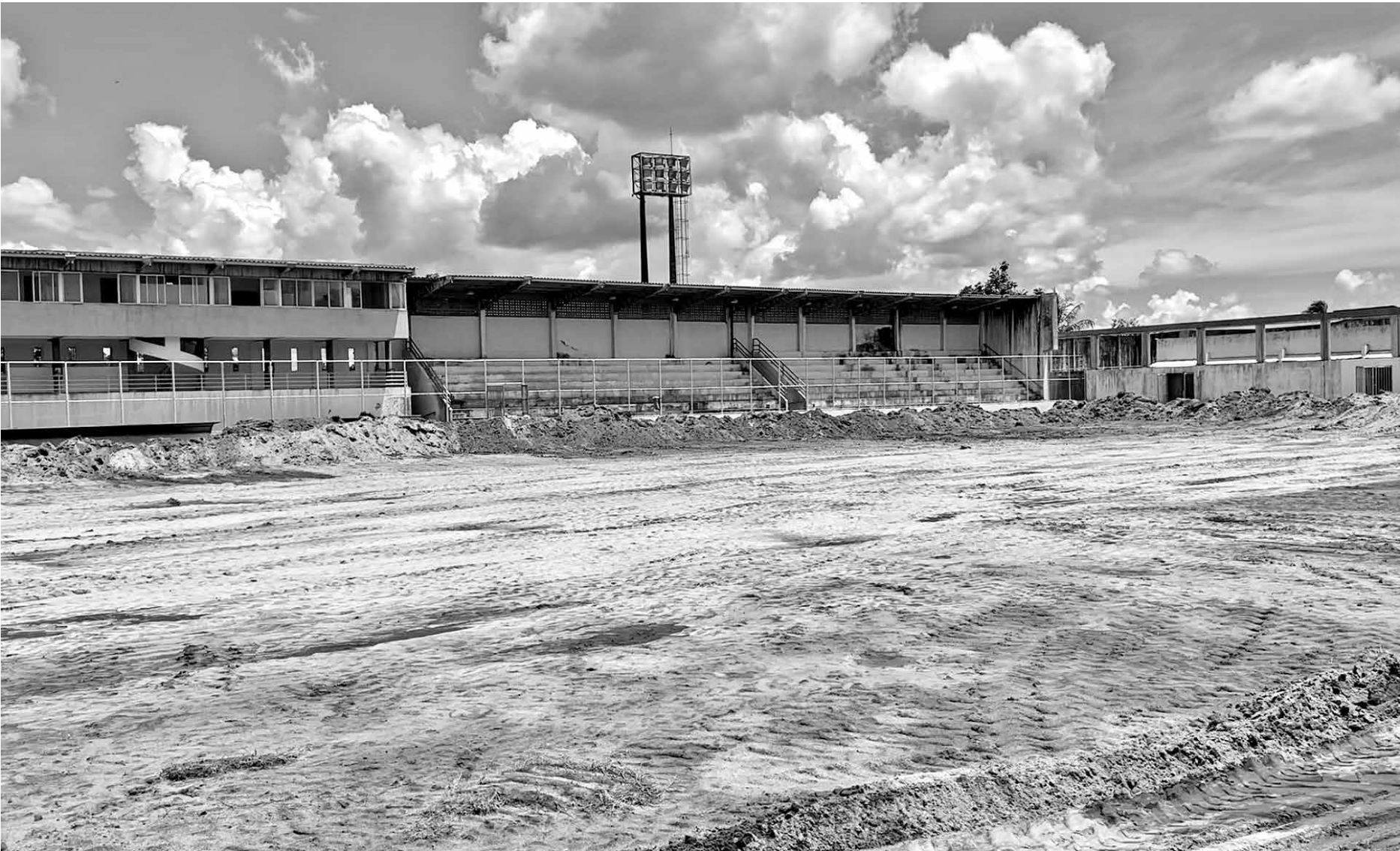
Gramado do Estádio da Graça já foi totalmente retirado e, nos próximos dias, começa a colocação da grama sintética, que vai beneficiar clubes amadores e profissionais
