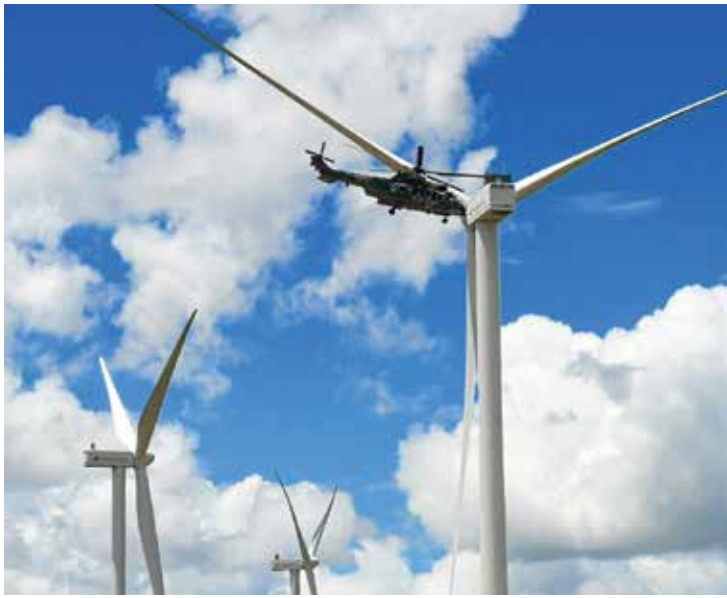
As torres eólicas já estão gerando energia limpa no Sertão
