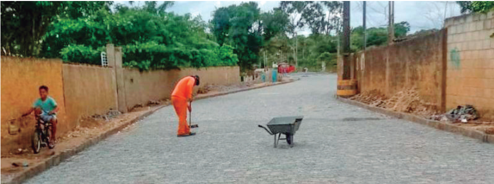
Operários trabalham na preparação dos trechos que estão recebendo pavimentação
