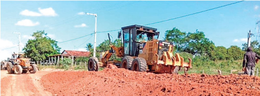
Obras na pista fazem o trabalho de terraplenagem para melhoramento de rodovias
