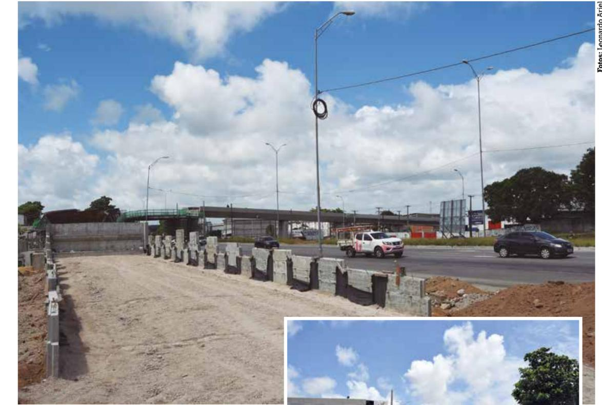
Atualmente, no lado do bairro Costa e Silva, estão sendo montadas as armaduras do caixão celular e da viga-laje; em paralelo, estão sendo executados os processos de montagem da terra armada e da terraplenagem
