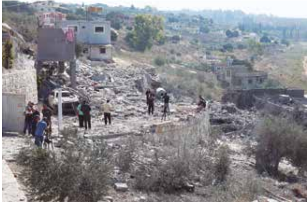
Quem retornou encontrou destruição e falta de serviços básicos
