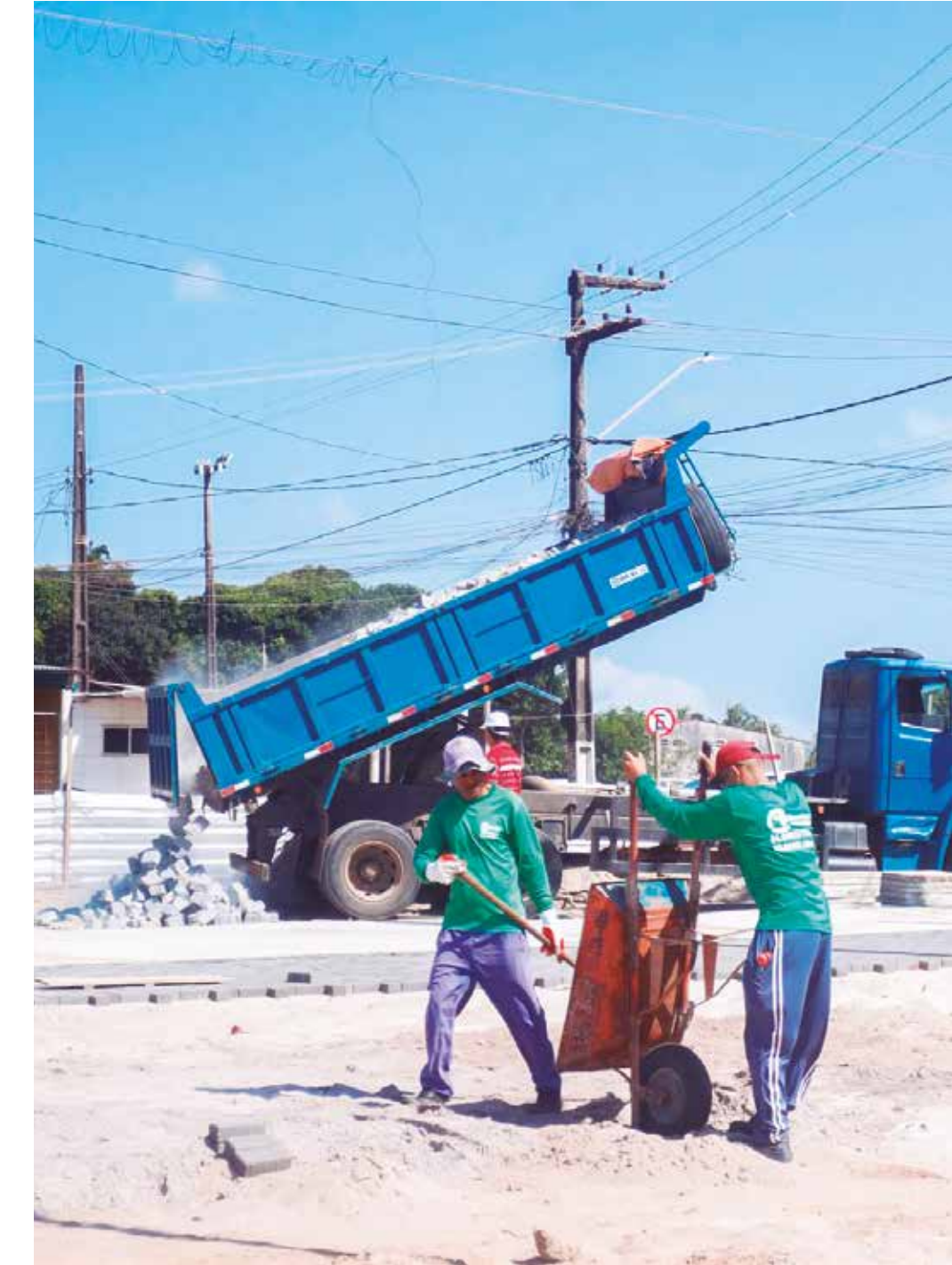
Atualmente, equipes executam serviços dos pisos intertravado e tátil e instalam luminárias
