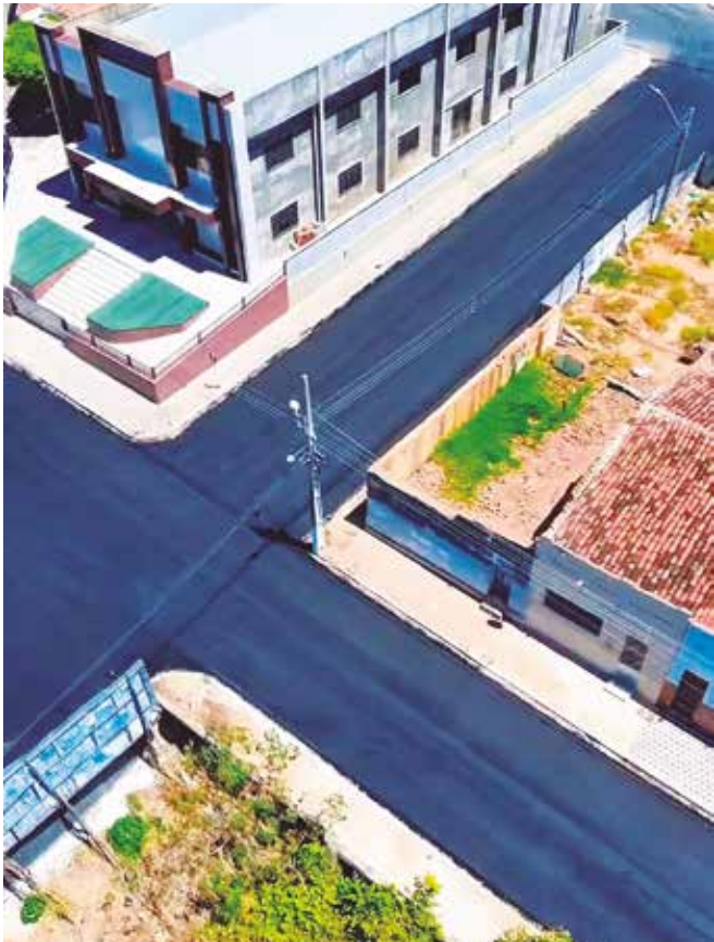
Obra tem extensão de 9,06 km e alcança 63 mil pessoas
