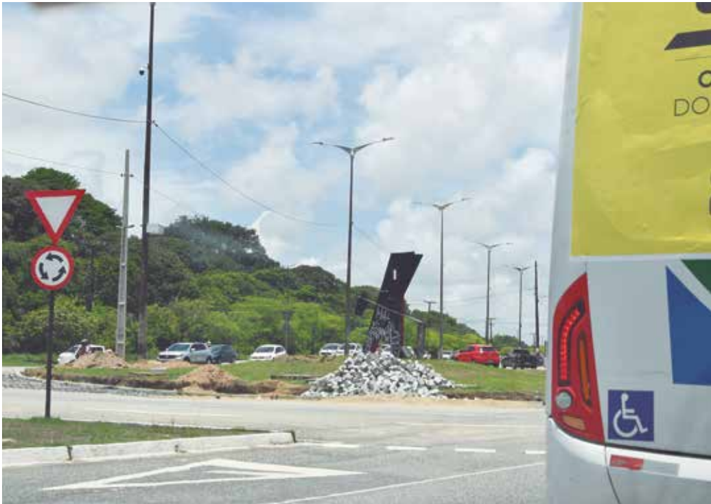
No canteiro, pode-se perceber, espalhado, um grande volume de material utilizado nos trabalhos
