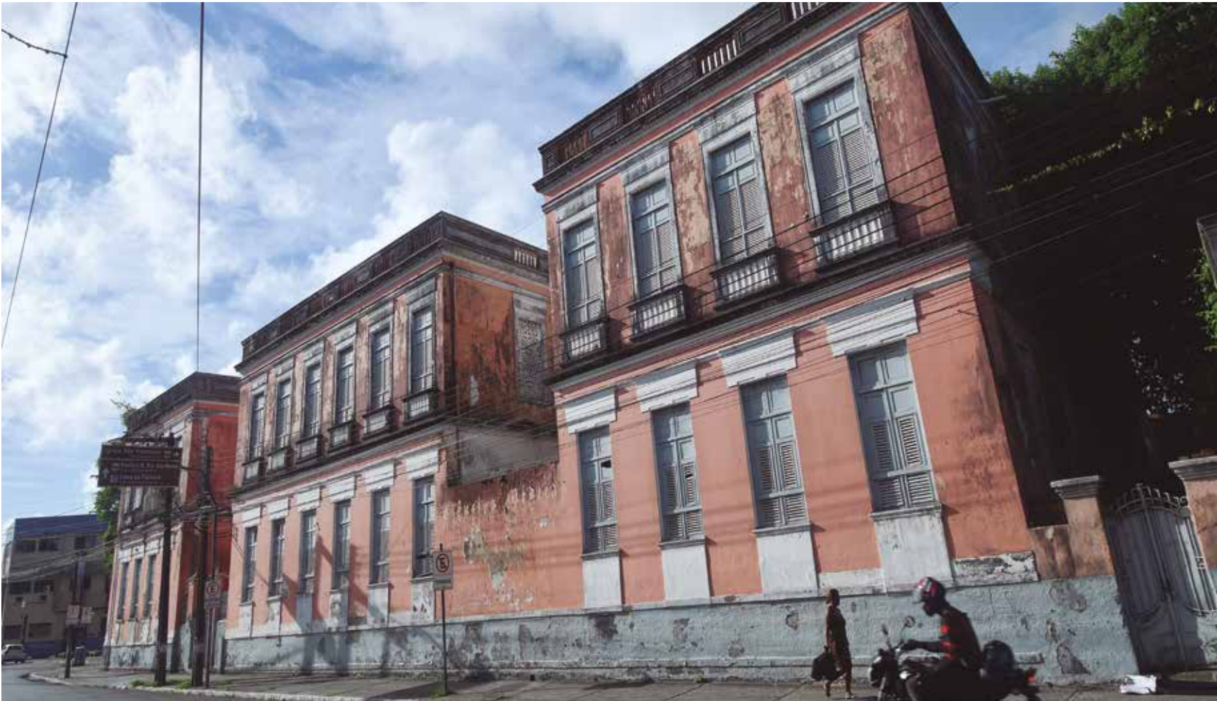
Antigo Colégio Diocesano Pio XII passará por obras de revitalização para se transformar em hotel; cerca de R$ 80 milhões serão investidos no local
