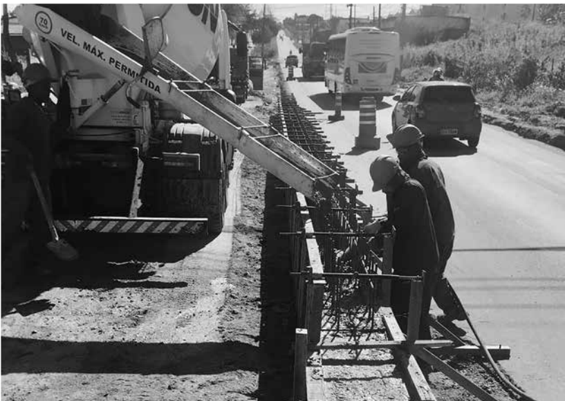
Em fase final de execução, trabalhos atuais incluem a execução de barreiras do tipo New Jersey (E), que absorvem o impacto dos veículos, e serviços de terraplenagem na alça de descida (acima)
