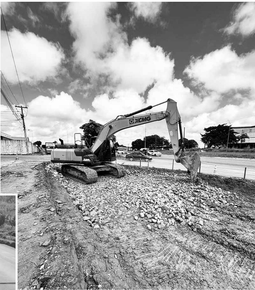
Em fase final de execução, trabalhos atuais incluem a execução de barreiras do tipo New Jersey (E), que absorvem o impacto dos veículos, e serviços de terraplenagem na alça de descida (acima)
