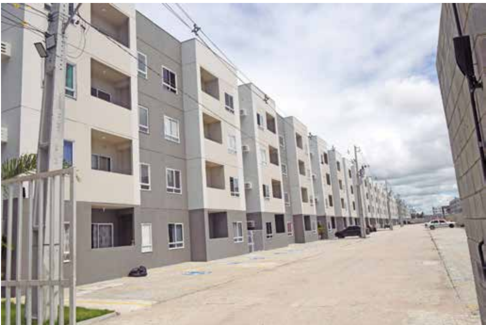
Recomendações incluem instalação de telas, grades de proteção e pisos antiderrapantes
