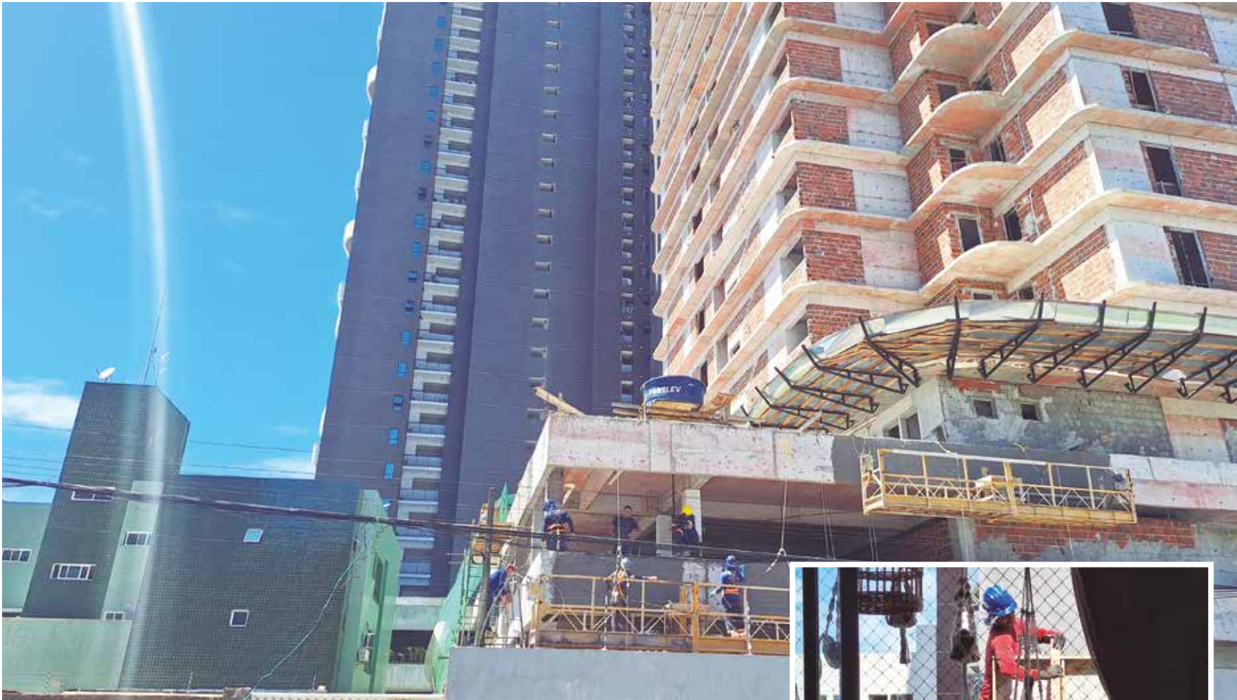
Moradores de residencial (em verde) do Jardim Oceania reclamam de obra barulhenta na vizinhança
