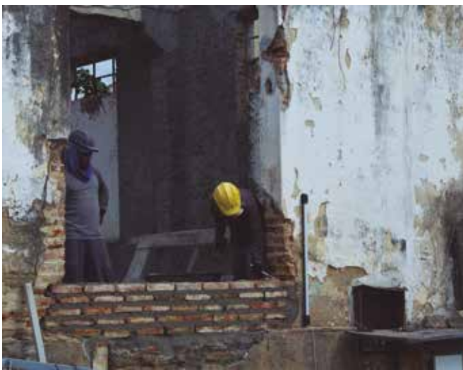
Demolição de paredes deve ser sujeita a análise técnica
