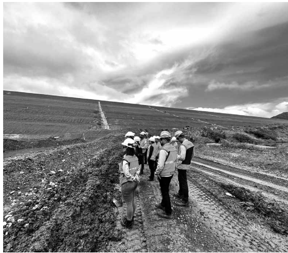
Agência teme que haja atraso nas inspeções técnicas de barragens e pilhas de mineração
