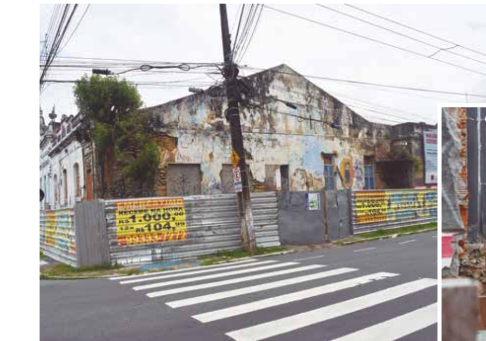
Atual etapa inclui escavações, execuções dos pilares e demolição de alvenarias não incluídas no projeto original
