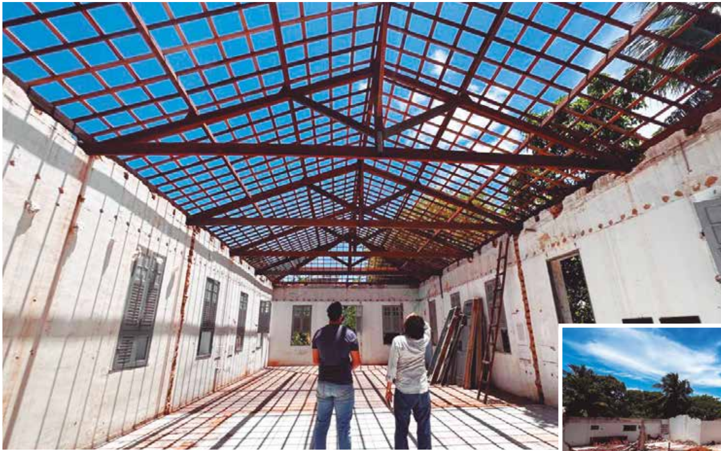
Em execução no Centro de JP, nova etapa da obra financiada pelo Governo do Estado soma investimento de R$ 10,6 milhões e deve ser concluída, integralmente, no próximo ano
