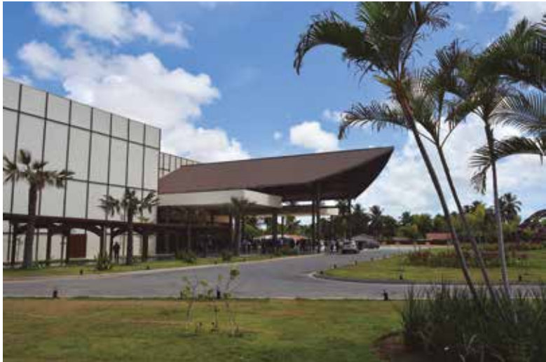
Empreendimento possui 1.128 apartamentos e seis restaurantes
