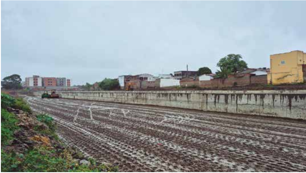
Conforme a prefeitura, intervenções abrangem pavimentação, ciclovias, calçadas e área gramada
