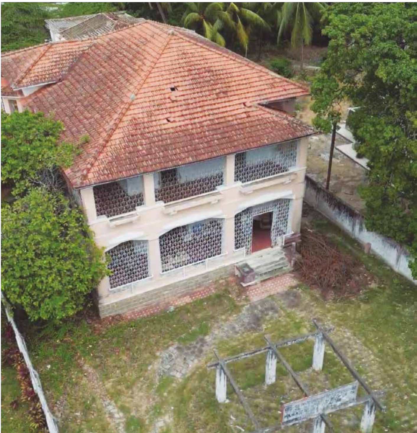
De acordo com a arquiteta Sandra Moura, obras de renovação da construção incluem mudança de cor e iluminação
