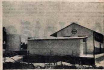
A FOTO acima foi tomada em Cabedelo, onde a "Standard Oil" construiu instalações para o recebimento de gasolina e "Fuel-Oil", abrindo novas perspectivas para a melhor distribuição de seus produtos, na Paraíba. As atividades das obras foram vistas, acompanhadas, pelo Chefe do Governo.
